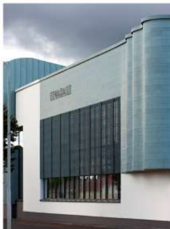
Pori Simhall Kopparfasad med inbyggd solvärmeutvinning
